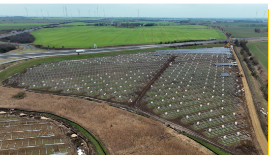
Das PV-Feld am Autobahnkreuz Uckermark von ENERTRAG während der Bauphase
